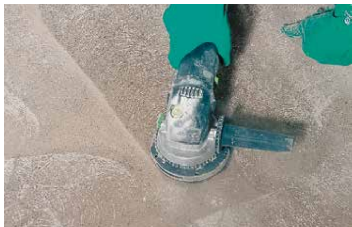
Zdjęcie 3. Do szlifowania lekkiego można stosować szlifierkę kątową.
