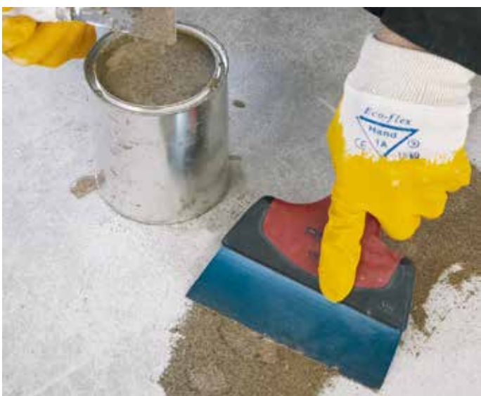
Zdjęcie 8. Przykłady łatania przed aplikacją lakieru podkładowego i po aplikacji.
