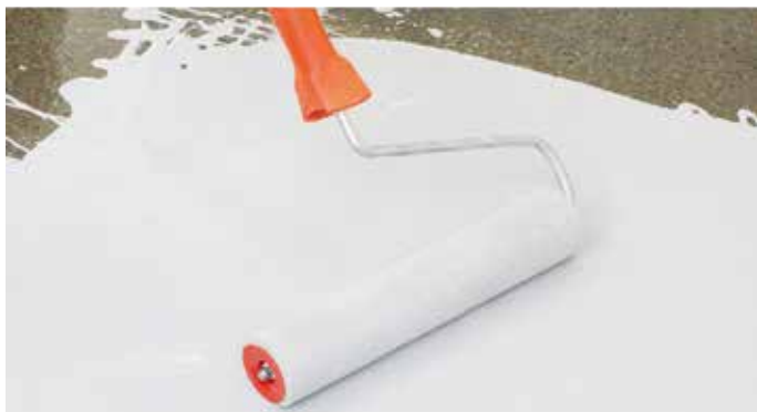
Zdjęcie 11. Malowanie posadzki betonowej.
