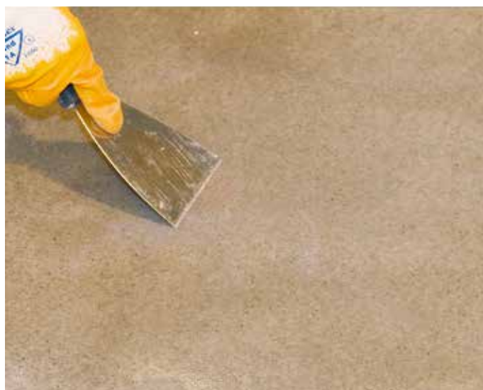
Zdjęcie 9. Łatanie dziur lub pęknięć. Dziury i pęknięcia należy łączyć nierozcieńczonym lakierem epoksydowym Temafloor 400 lub gruntem Fontefloor EP Primer i suchym, czystym piaskiem. Stosunek mieszania, np. 1 część obj. mieszaniny epoksydowej i 1, 2 obj. części piasku o grubości ziarna 0,1-0,6 mm. W przypadkach specjalnych, gdy pęknięcia są szerokie, należy naciąć posadzkę, a rowki zaprawić. Przed nakładaniem powłok nawierzchniowych zalatane obszary należy zeszlifować.
