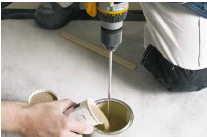
Zdjęcie 7. Mieszanie lakieru z suchym, czystym piaskiem.
