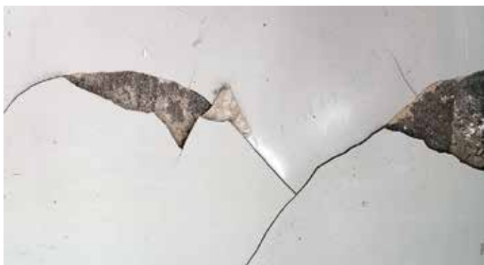
Zdjęcie 5. Kiedyś impregnowana posadzka betonowa. Przed aplikacją należy usunąć starą, łuszczącą się powłokę.
