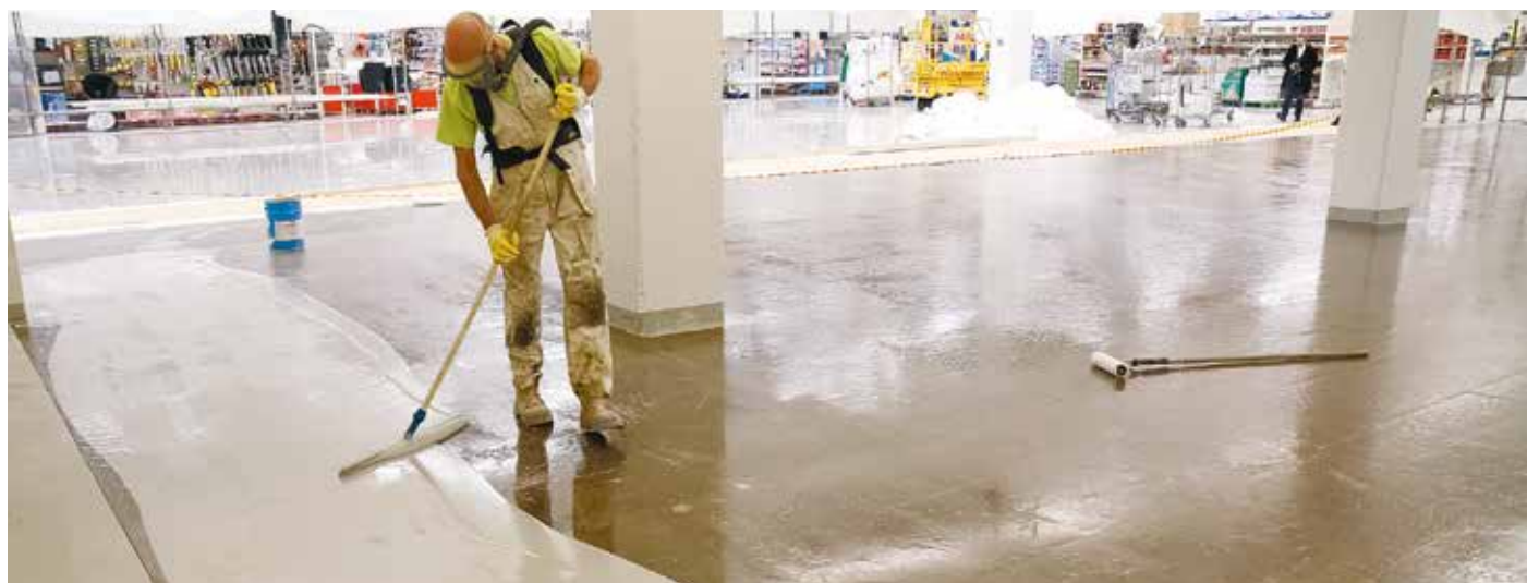
Zdjęcie 2. Tarjoustalo. Temafloor P300 w trakcie nakładania.
